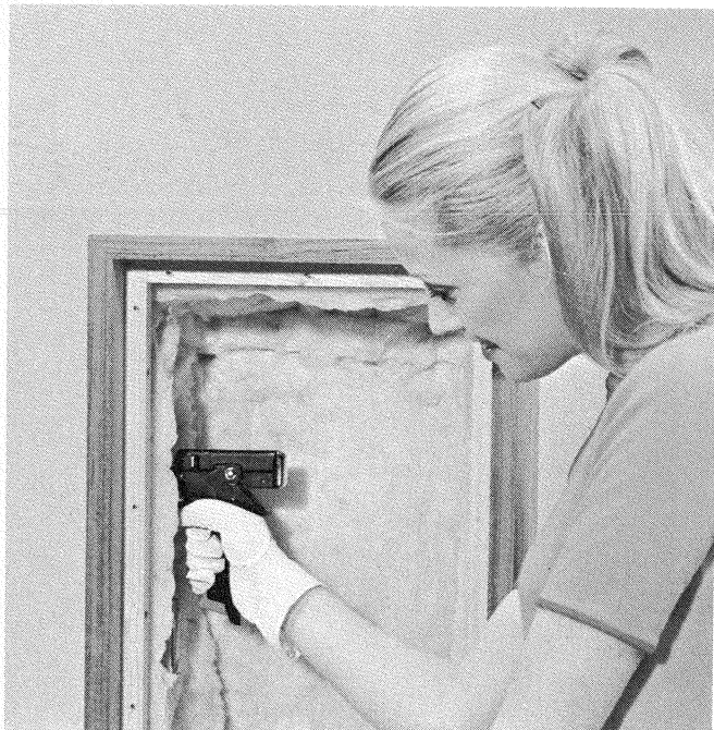
Fig. 9 - La lana di vetro, necessaria per lo smorzamento dei bassi, va fissata mediante una cucitrice (o altro sistema analogo)
